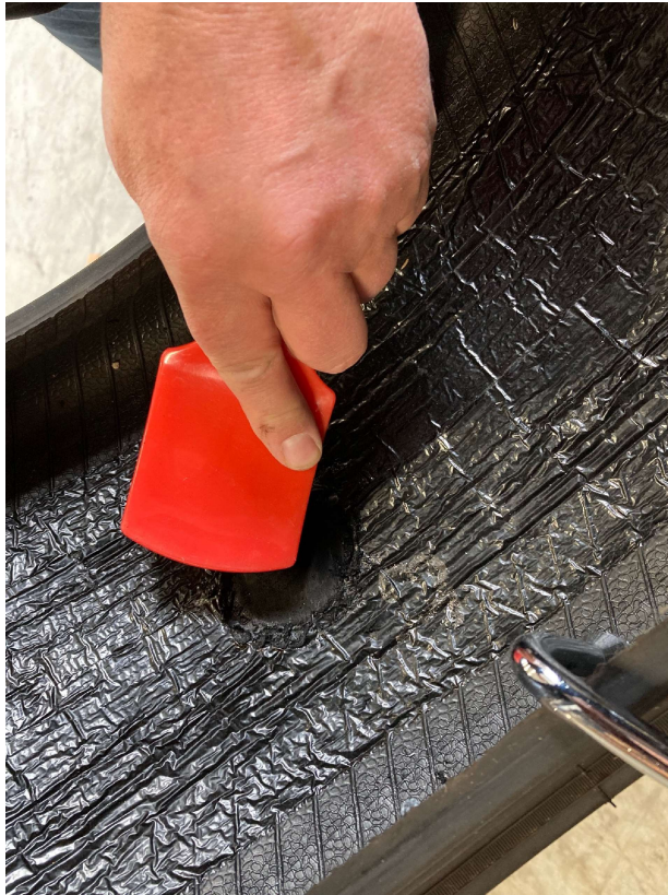
Overfladen børstes ren for raspestøv.
