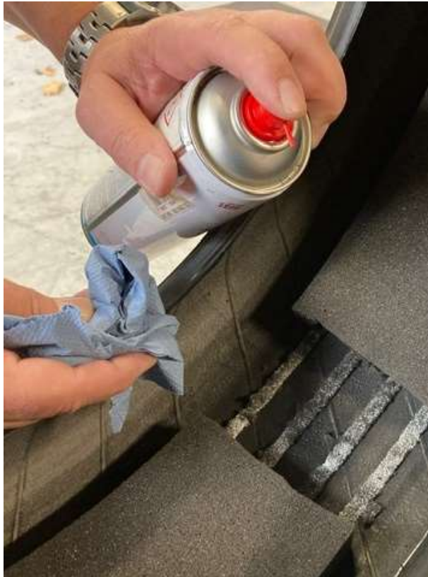
Skadesstedet renses med Liquid Buffer.
